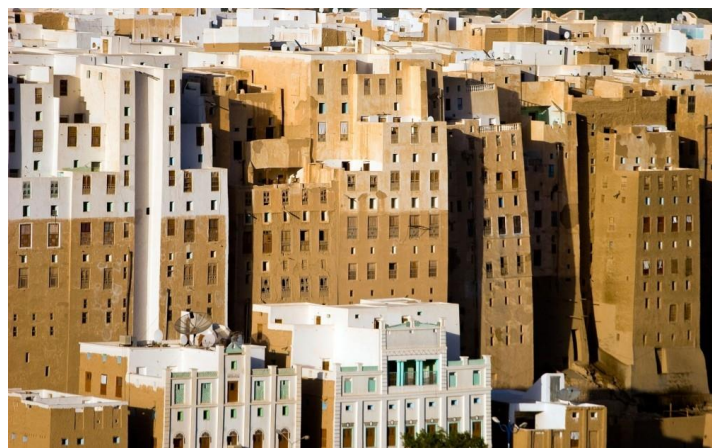
写真2 南イエメン シバーム 木筋泥壁高層建築群 セメント不要の伝統都市 事例
