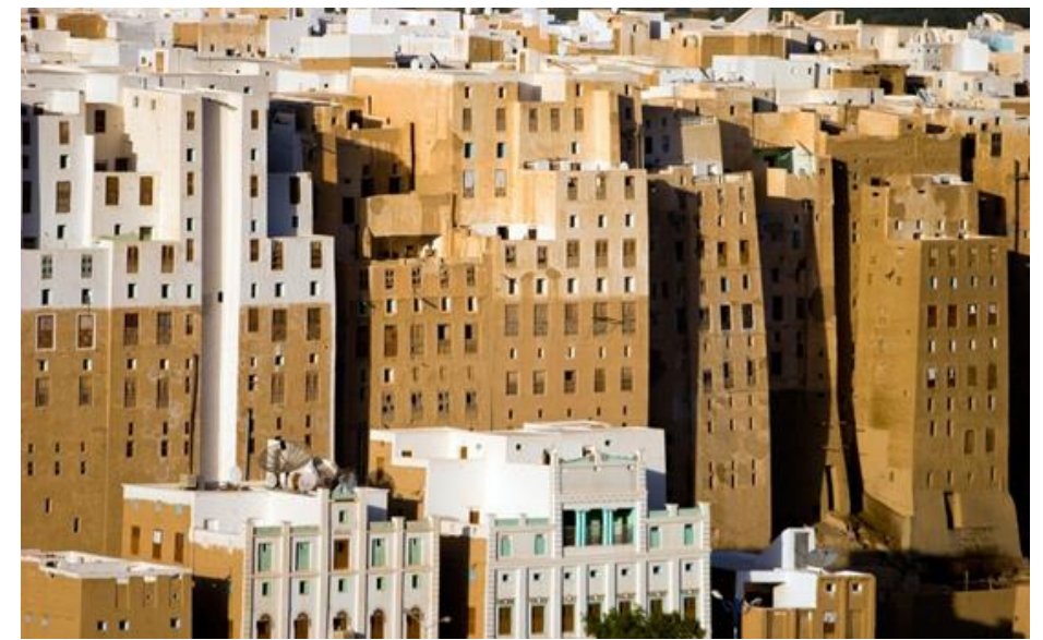
南イエメン シバーム 木筋泥壁高層建築群
