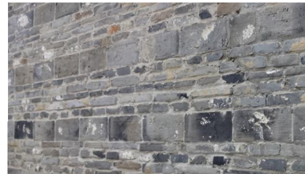
セメント不要の伝統壁 事例 中国 鳥鎮(水辺伝統集落)にて 撮影
