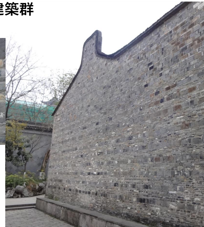
セメント不要の伝統壁 事例 中国 鳥鎮(水辺伝統集落)にて 撮影
