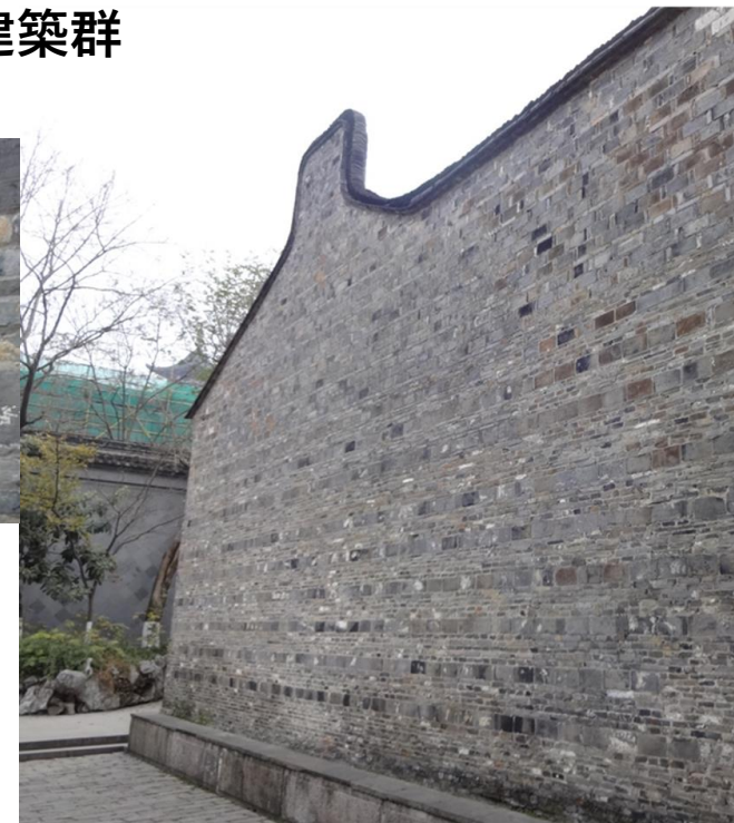
セメント不要の伝統壁 事例 中国 烏鎮(水辺伝統集落)にて 撮影
